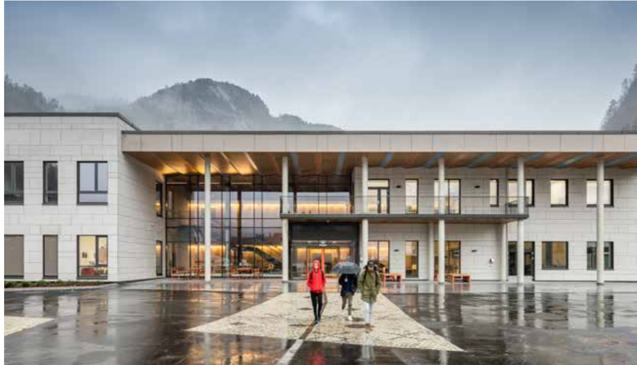
UNG MØTEPLASS. Det nye biblioteket i Dale ligger i den nybygde barne- og ungdomsskolen.
